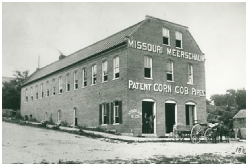
Fabrica de Tijolos de 1880.
